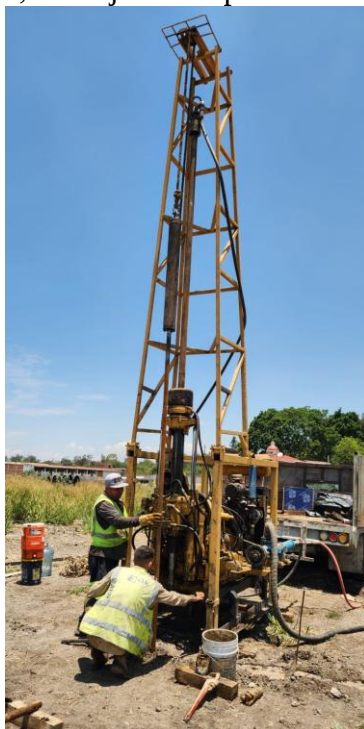
Fotografía 2, Trabajos de exploración en el SPT-2.
