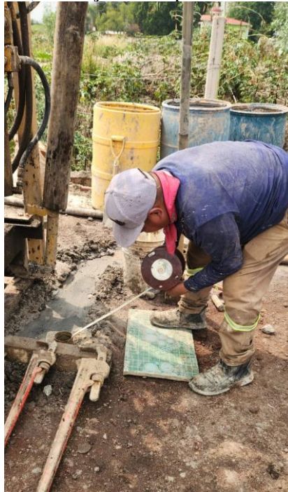
Fotografía 4, Prueba de permeabilidad en el SPT-1.
